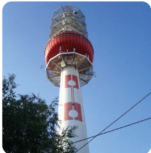
Antenne TDF © Ville d'Artigues-près-Bordeaux
